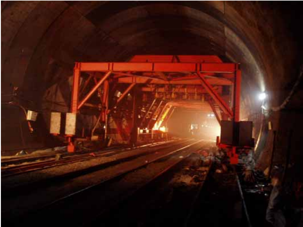
照片 1 環片拆除高架平台前端及環片昇降平台
