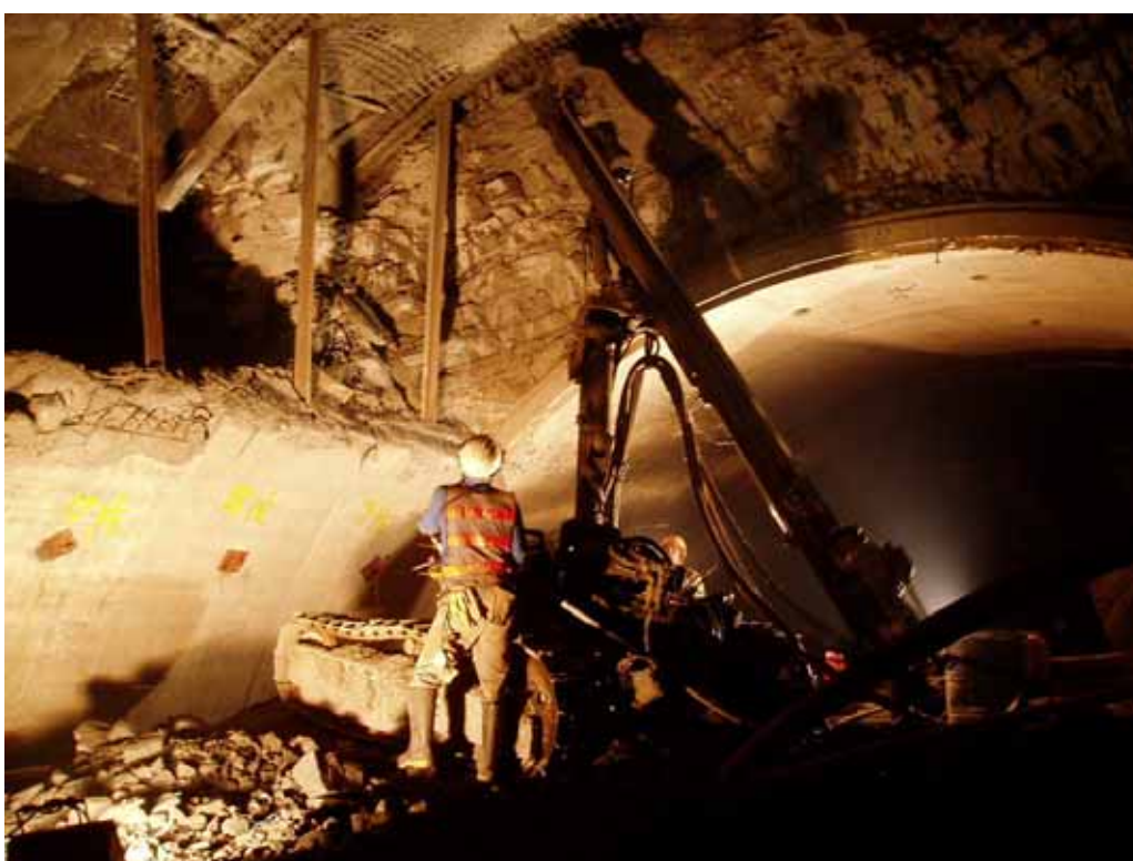
照片 10 頂拱擴挖後岩栓鑽設
