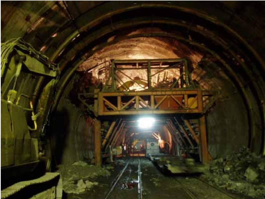
照片 4 環片拆除高架平台下方動線
