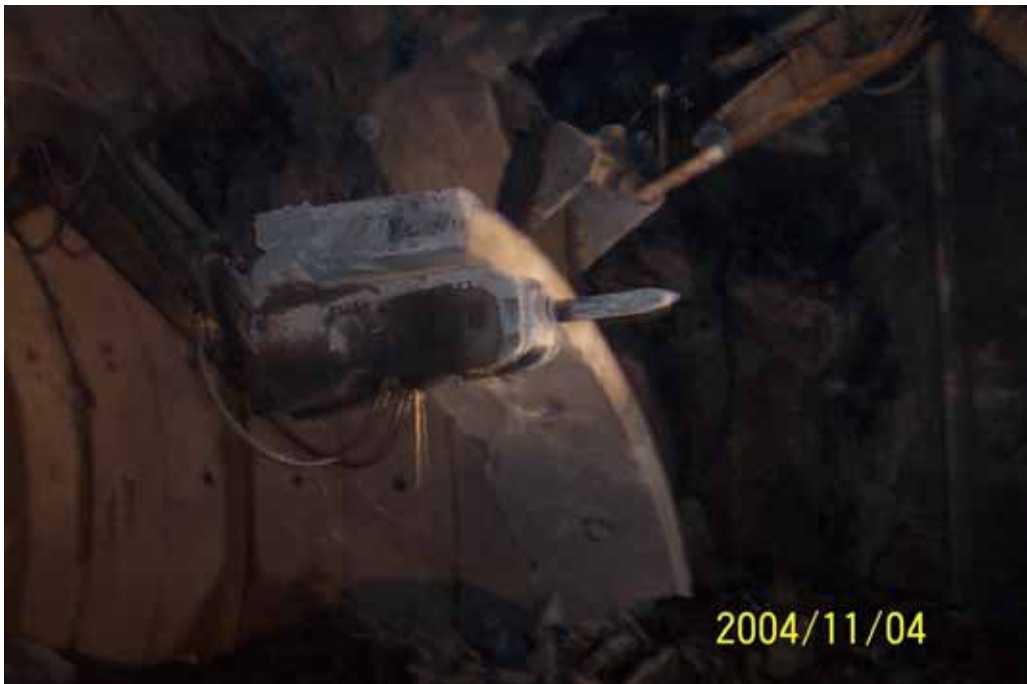
照片 11 B、C 環片拆除
