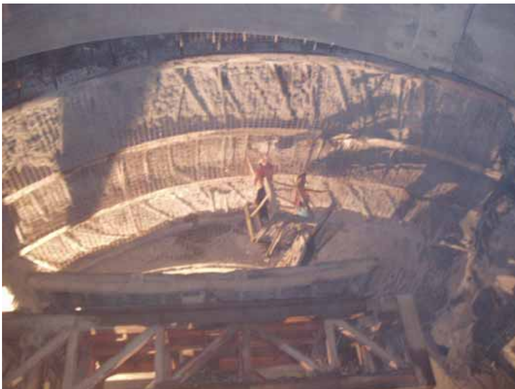
照片 9 頂拱擴挖後鋼線網組立
