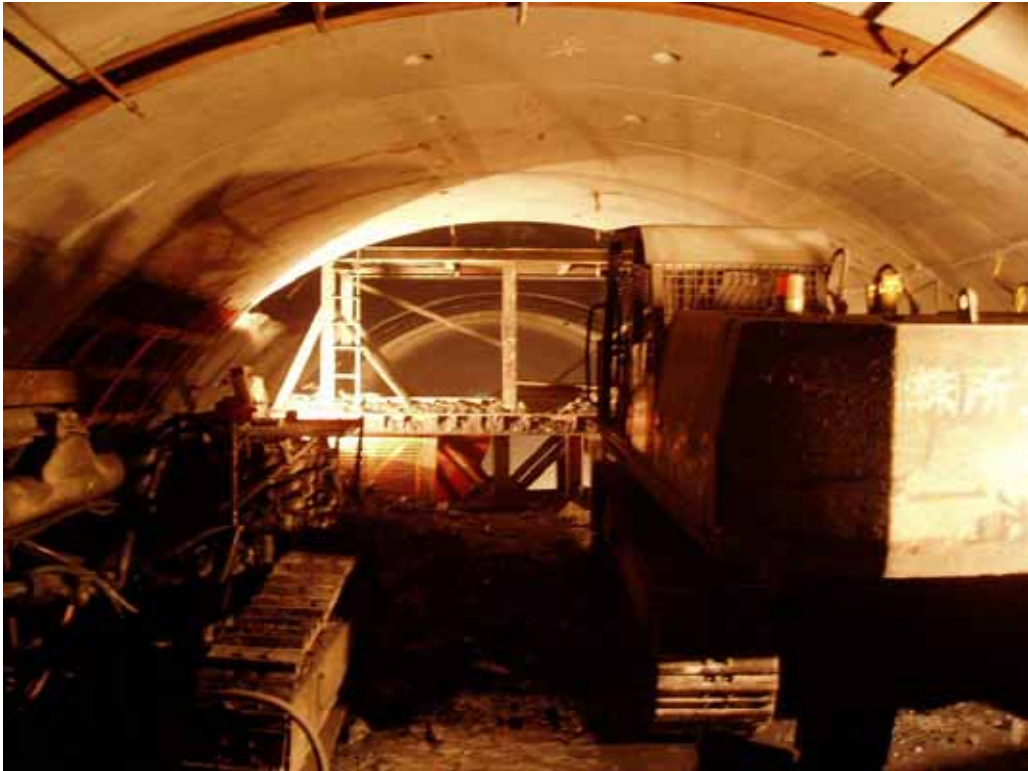
照片 3 環片拆除高架平台上佈設情形
