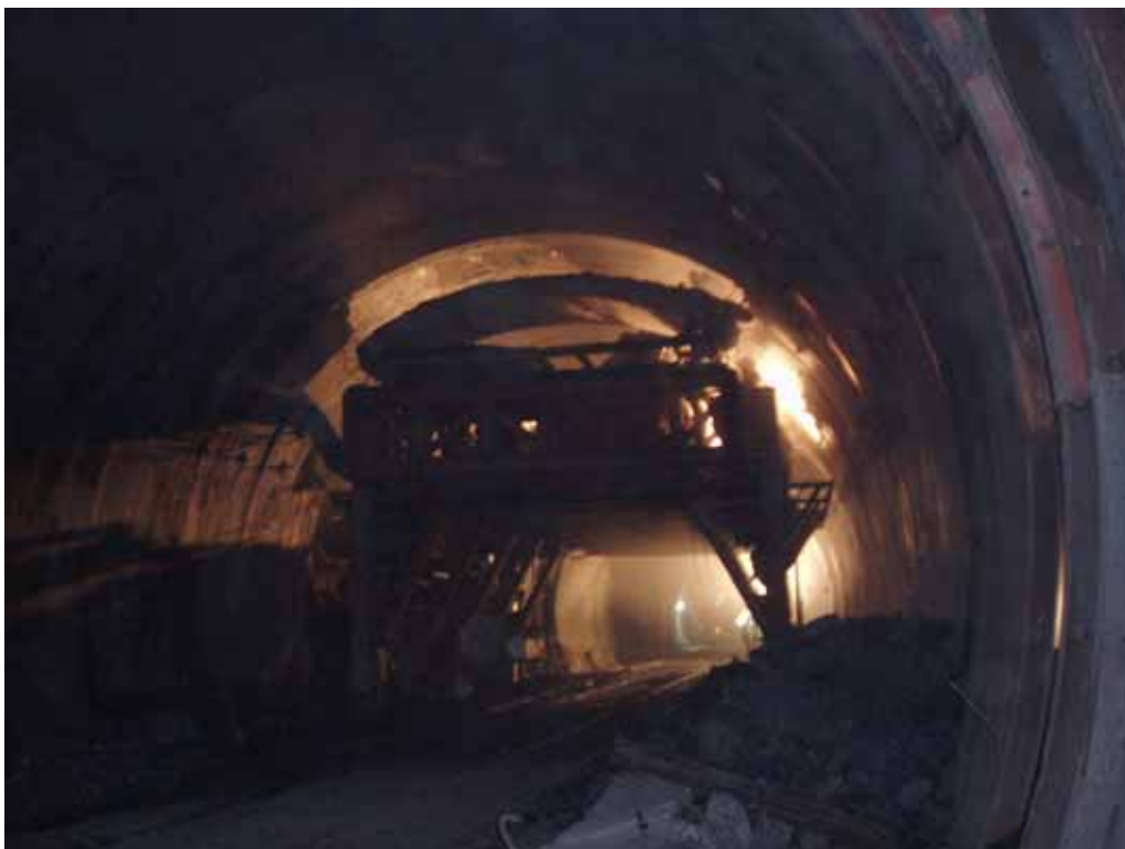
照片 5 A 環片拆除落於環片昇降平台上
