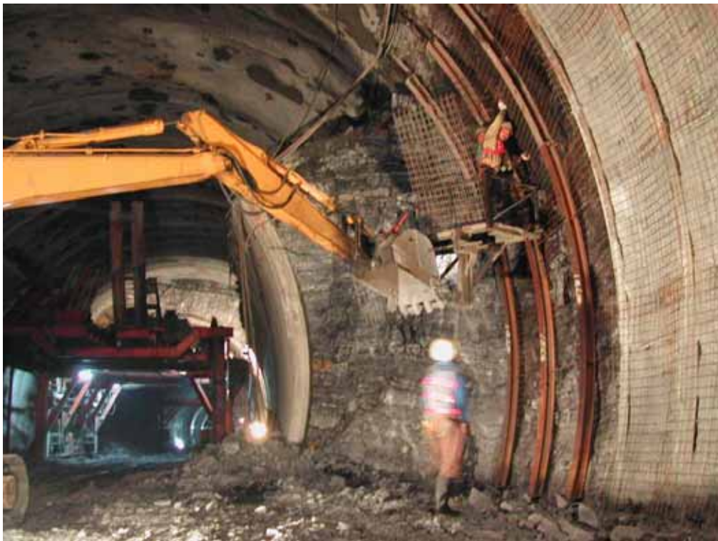
照片 12 洞台擴挖後鋼線網、鋼支保組立
