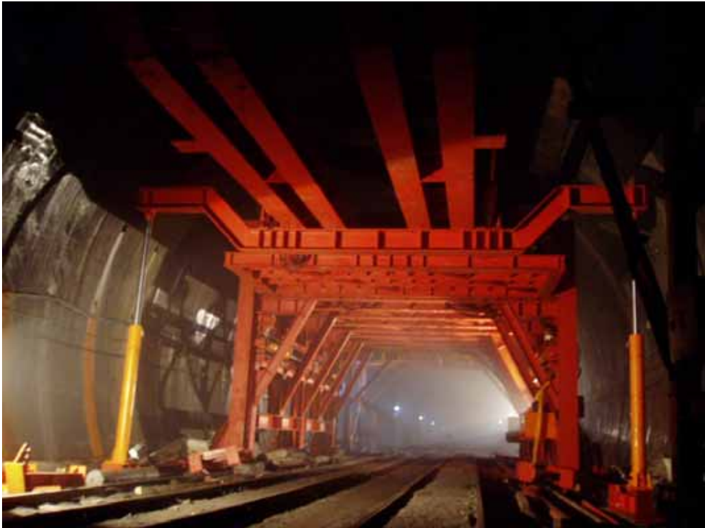
照片 2 環片拆除高架平台後端及活動棧橋
