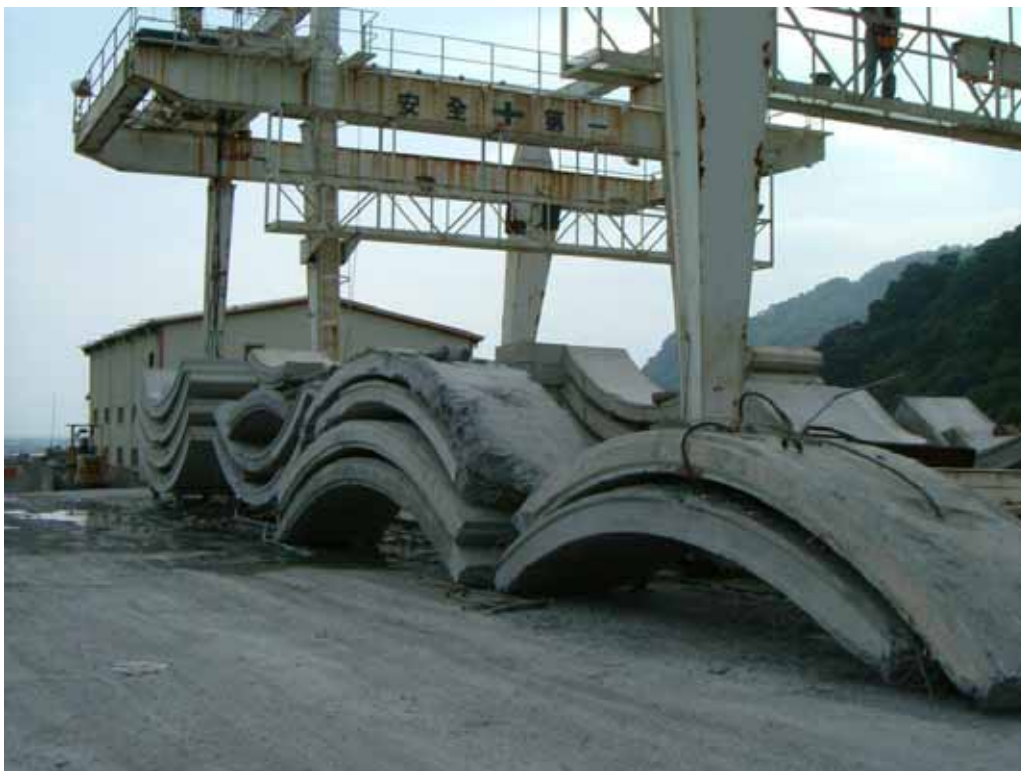
照片 7 拆除之環片運出隧道暫置
