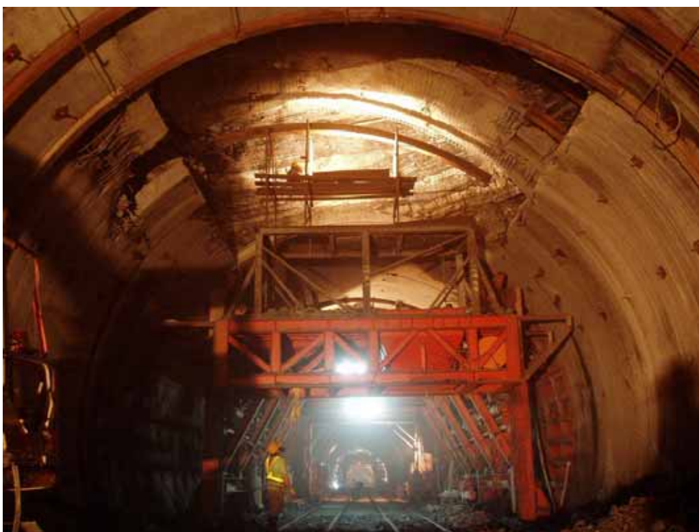
照片 8 頂拱擴挖後鋼支保組立
